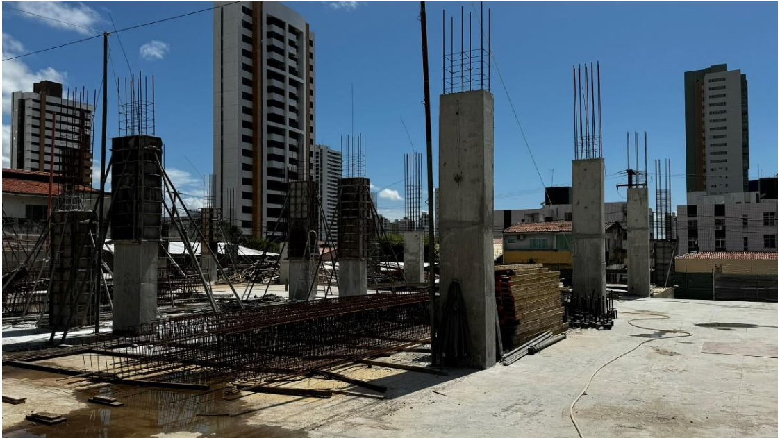
Figura 2. Concretagem do segundo trecho dos Pilares do segundo subsolo.
