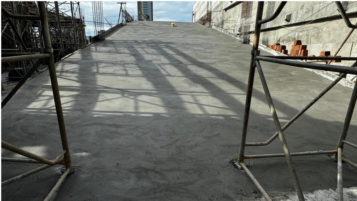
Figura 8. Concretagem da rampa de acesso ao primeiro subsolo.
