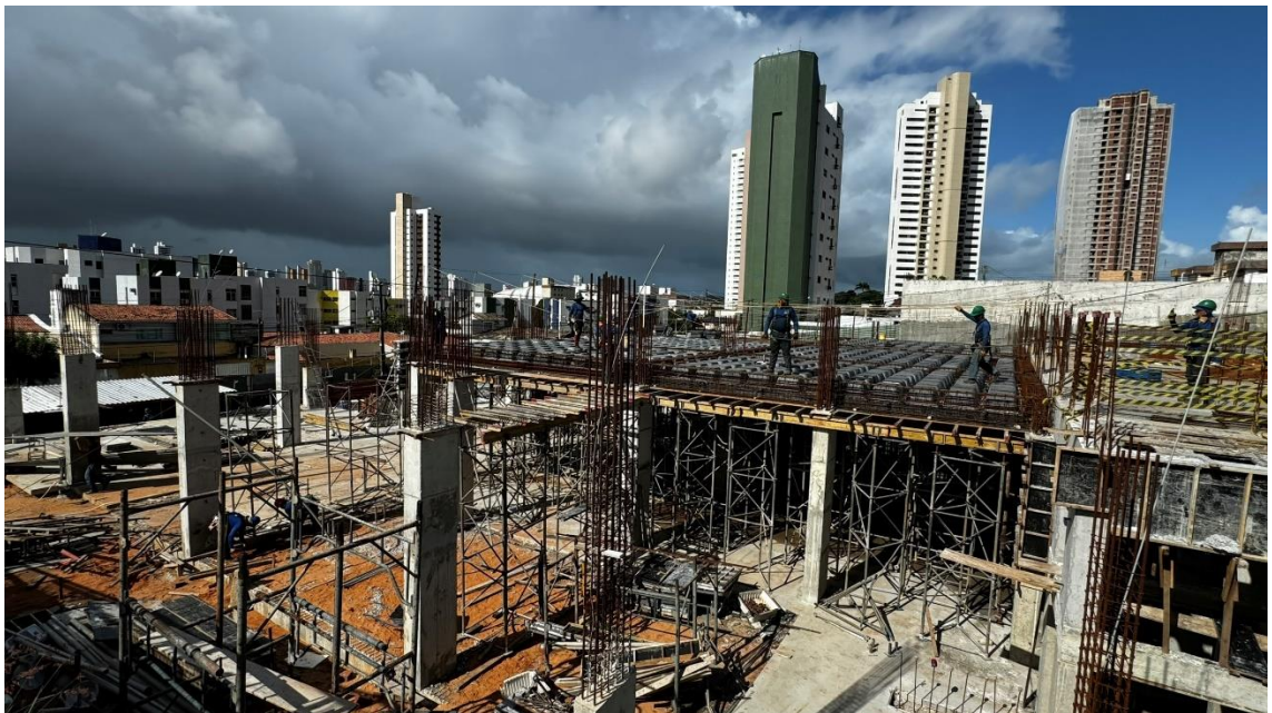
Figura 3. Visão geral dos pilares do segundo subsolo e de parte da laje de cobertura do segundo subsolo.
