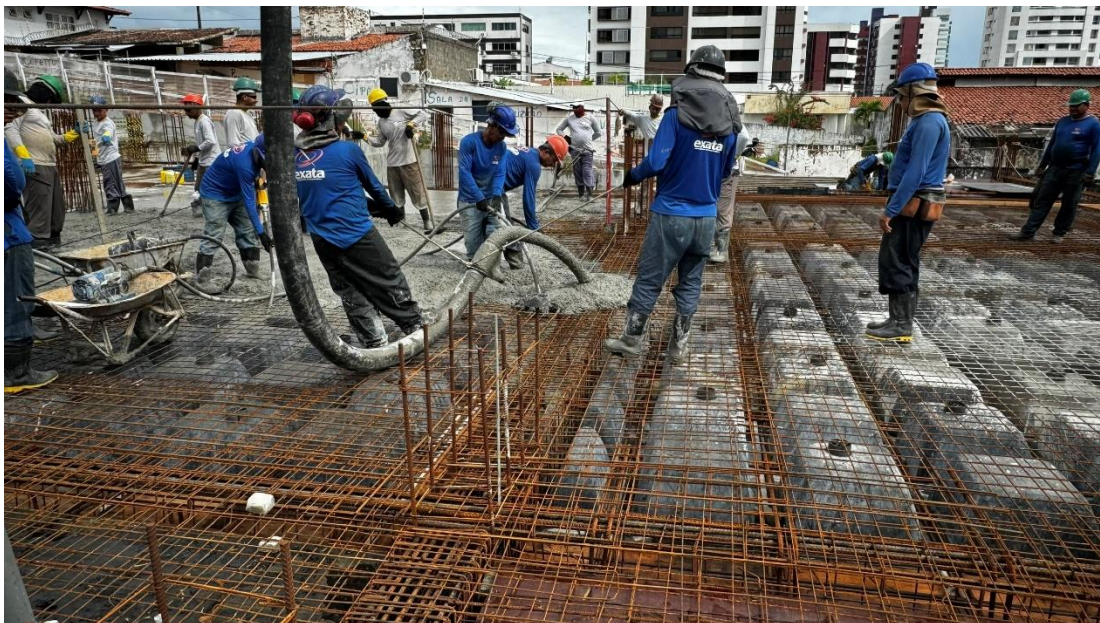
Figura 4. Local da laje do segundo subsolo onde foi concretada parte da laje de cobertura do segundo subsolo.
