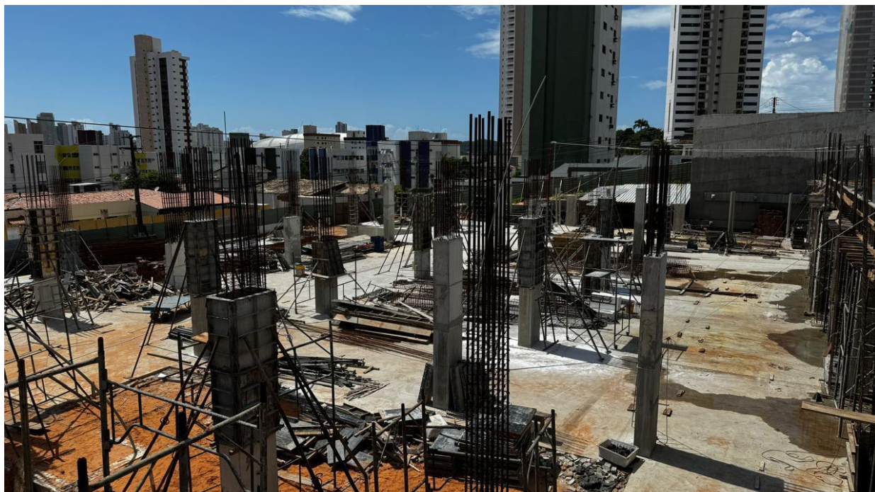
Figura 9. Instalação dos Re-Bar nos pilares.
