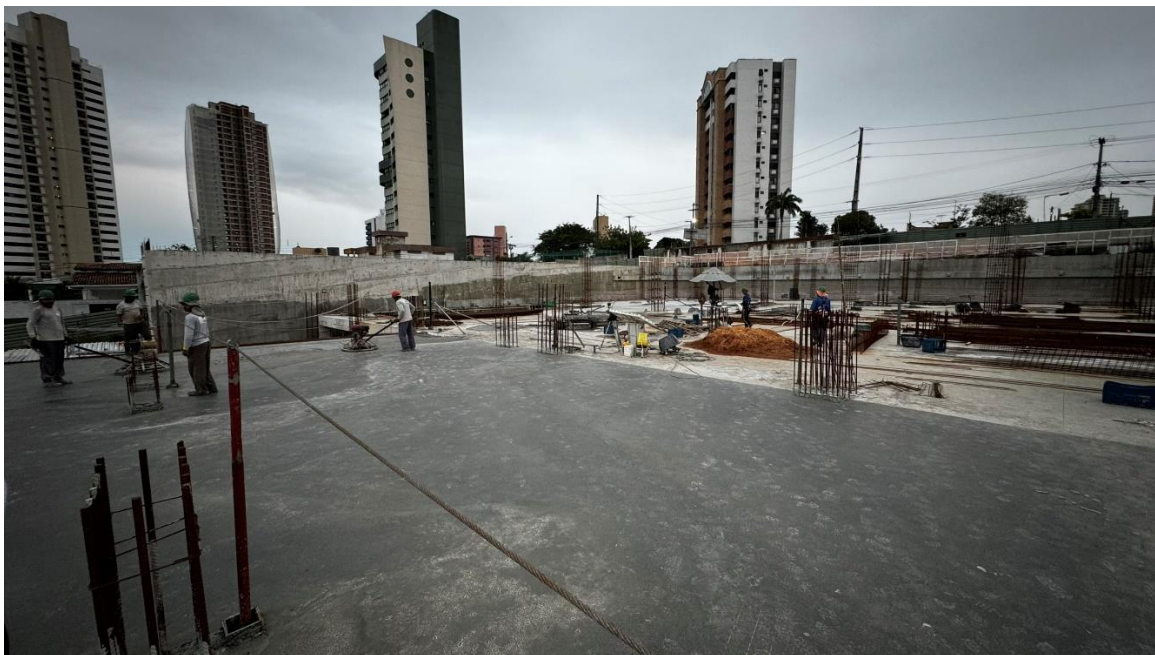
Figura 6. Laje de cobertura do segundo subsolo concretada.
