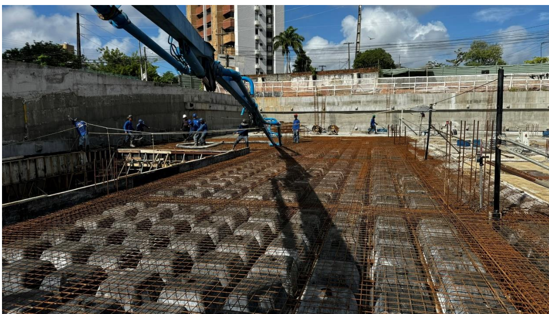
Figura 5. Concretagem de trecho da laje de cobertura do segundo subsolo.
